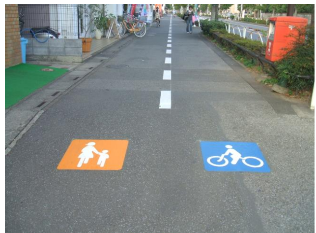
（写真2）通行帯を示すマーク
