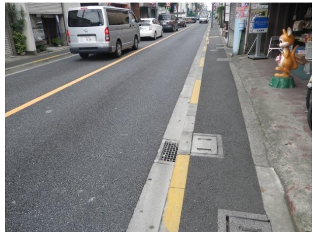
巻末写真4 側溝の傾斜と段差に前輪をとられる
