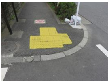
図4-2 転倒事故を起こさせる路面状況で、眼の不自由な人のための誘導帯・横断歩道と歩道との間の段差
