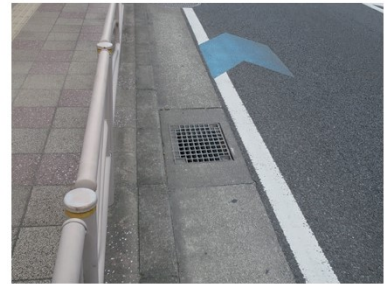
写真2 側溝上にある排水溝
