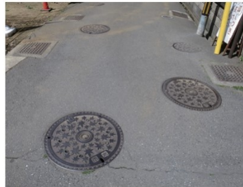
写真3 マンホール…が多数ある道路
