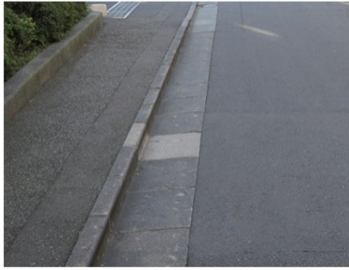
写真1 道路面と側…間にある切れ目
