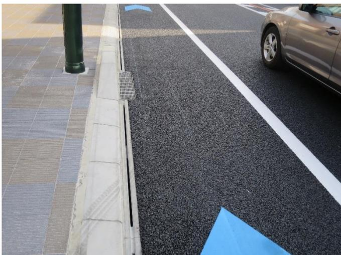
写真12 車道端の排水溝部分が平坦化されて自転車通行の安全性が向上
