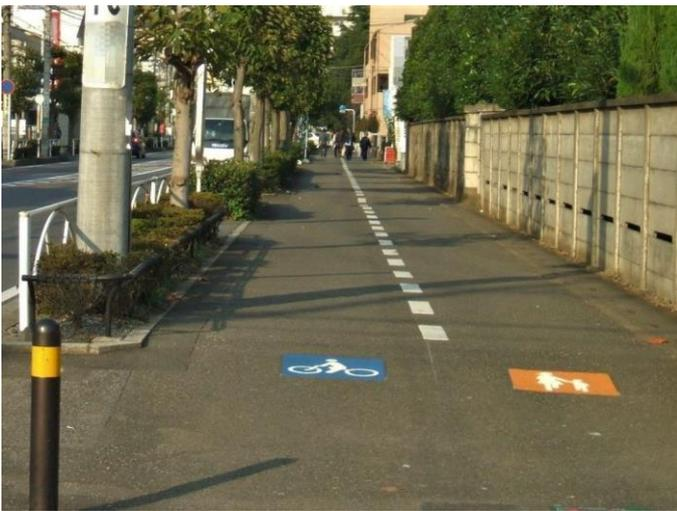
写真4 自転車が通行できる歩道で路面に自転車イラストと白線を描いて自転車の通行位置を指定した「自転車通行指定部分」
